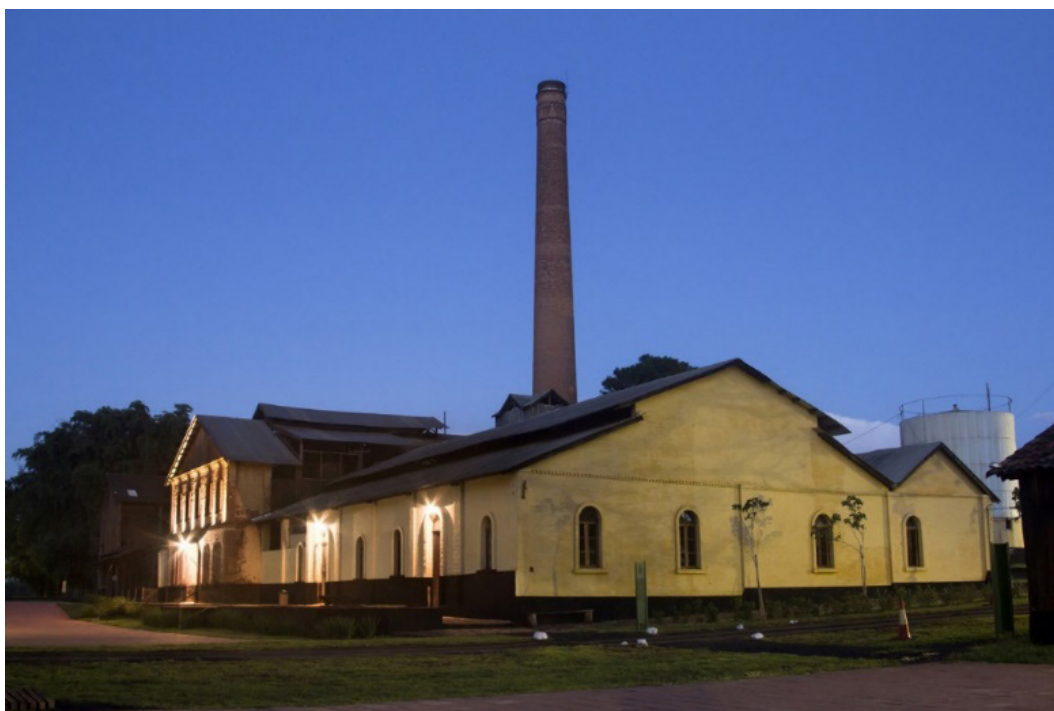
Figura 1. Lateral da edificação principal do Museu da Cana.
