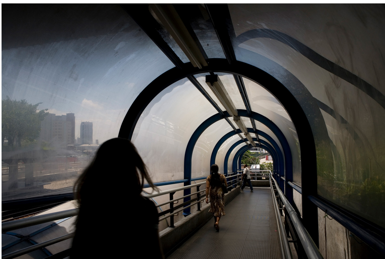
Estação Barra Funda, São Paulo, SP, 2011
